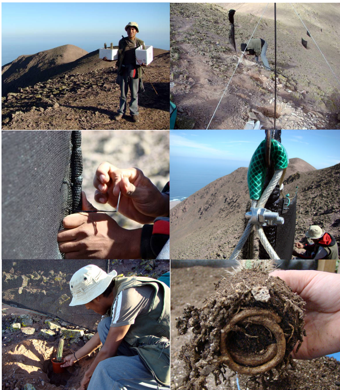
FOTO 27. Se lograron instalar tres atrapanieblas al día con tres personas necesarias para el acarreo de plantas y materiales para la Instalación de atrapanieblas, largueros, estacas de fierro, cable de acero, malla raschel, rejillas, combo, chuzo y otros. La última foto muestra que esa planta estuvo mucho tiempo en un macetero muy chico sin hacer el repique por lo que su raíz creció en círculo.
