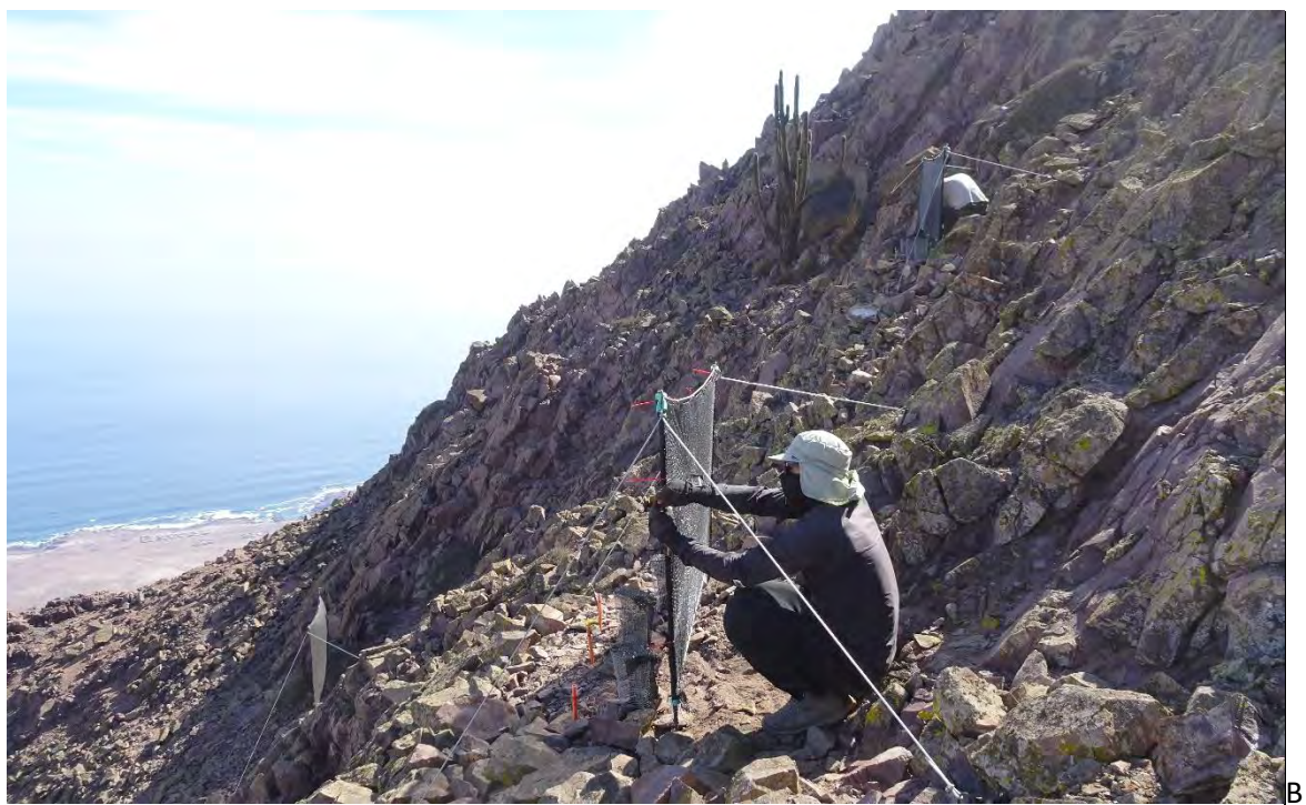
FOTO I.III.1. Instalación de atrapanieblas. A. Largueros y tensores. B. Amarre de la malla raschel.
